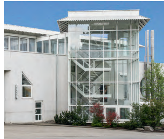
BITZ Deutschland, Logistikzentrum 1984 gegründet, 2008 Umbau zum Logistikzentrum
